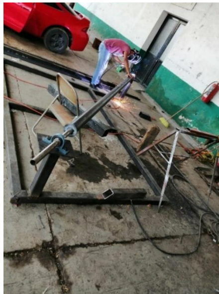
Ilustración 54. Fijación de flecha mediante soldadura.
